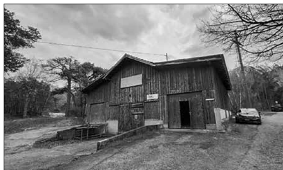
Gebäude alte Drescherei
